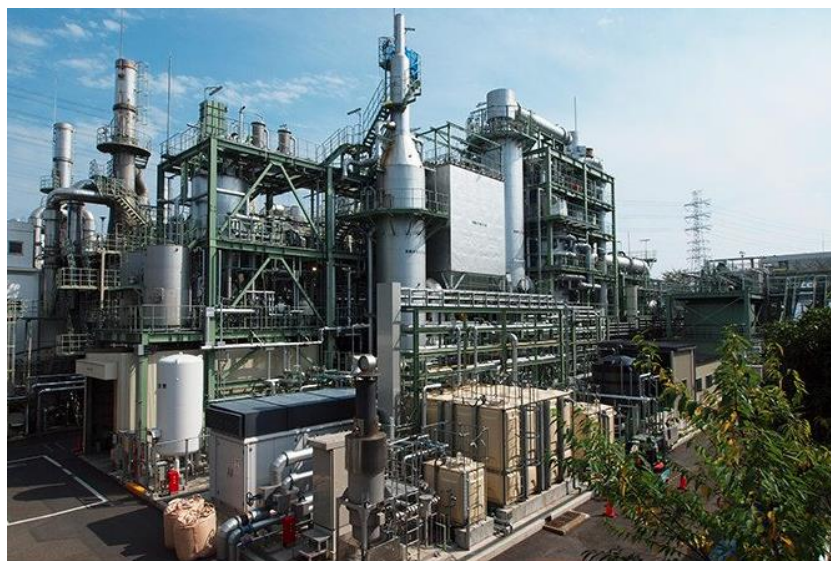
東京都下水道局清瀬水再生センターに設置された下水汚泥ガス化発電システム
