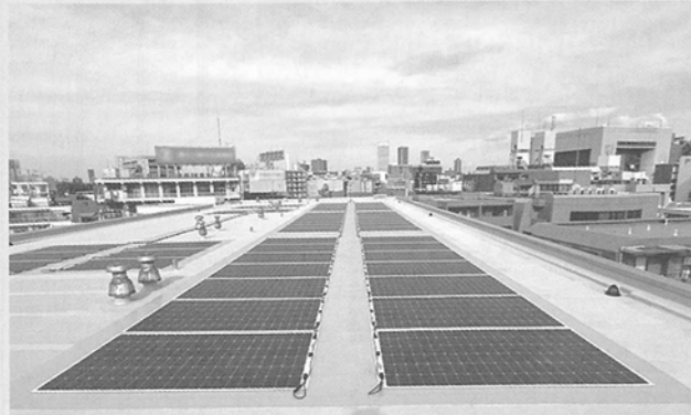
「フレキシブルソーラーG+」を設置した様子
